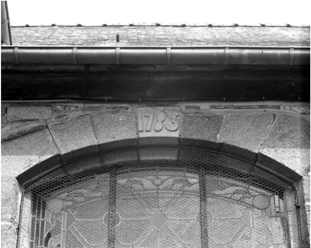
Elévation nord, partie est, fenêtre datée : détail de l'inscription
