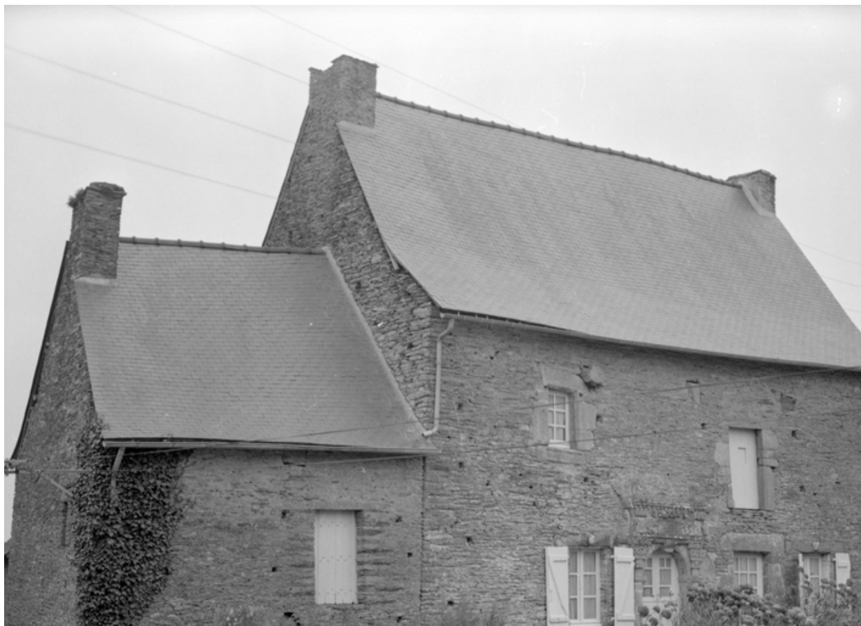
Maison : élévation nord (état en 1985)
