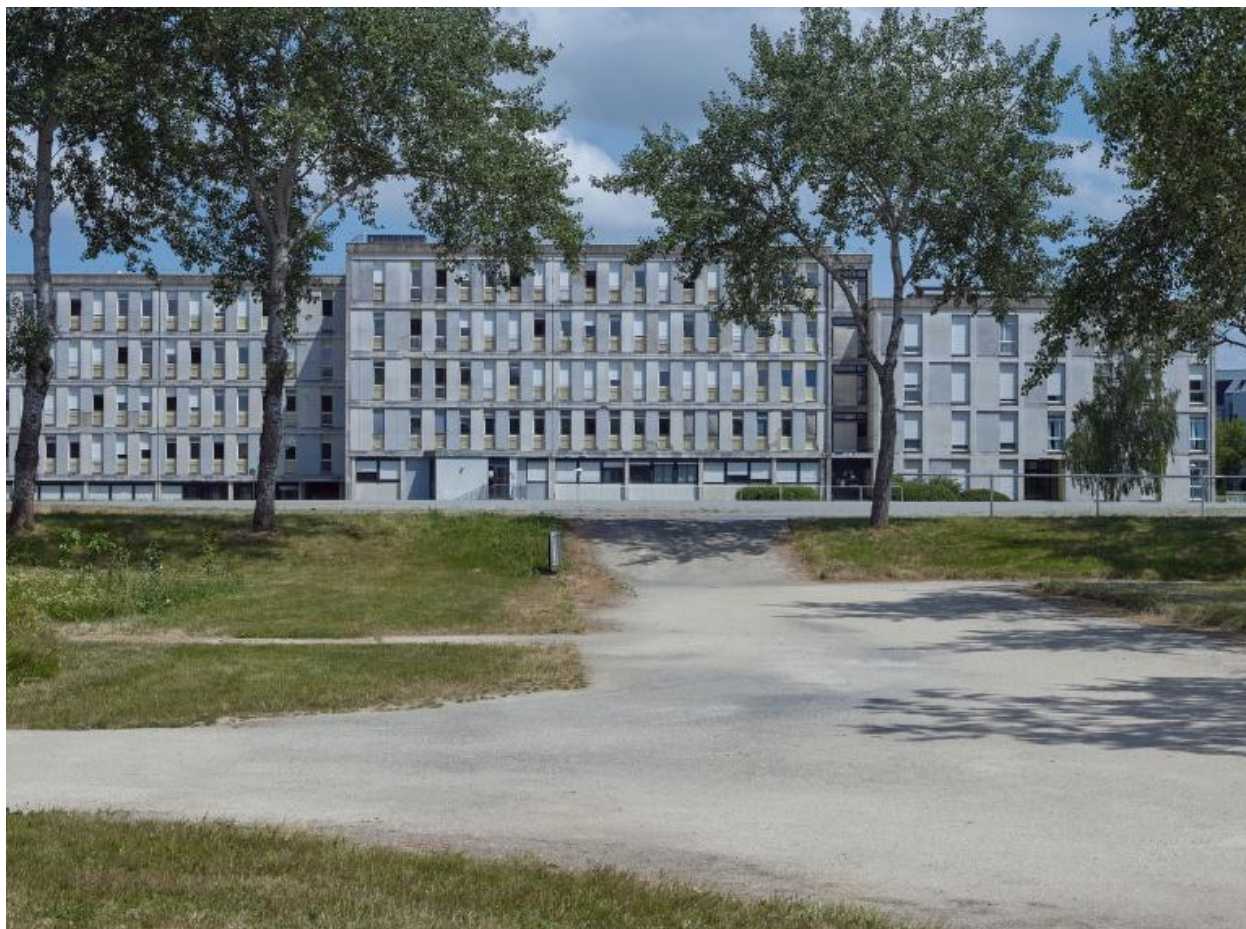
Façade ouest de l'internat de garçons : vue d'ensemble partielle et vue de situation. Louis Arretche et Jean Lemercier, architectes, 1967
