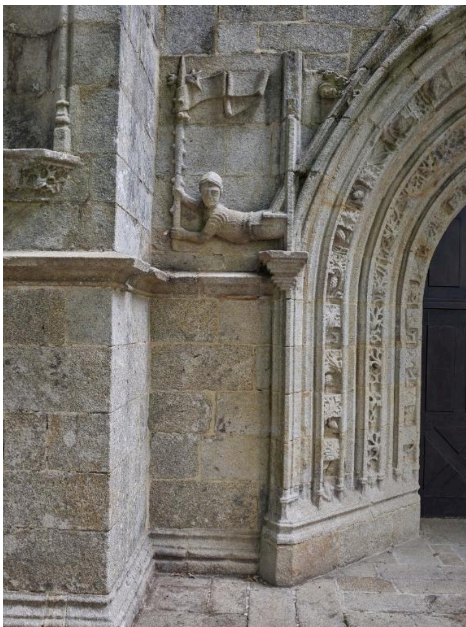
Ebrasement gauche du portail de la façade ouest
