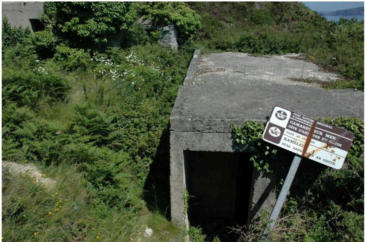
Vue de l'un des abris en béton armé implanté sur la plate-forme de la batterie de côte (état en 2005)
