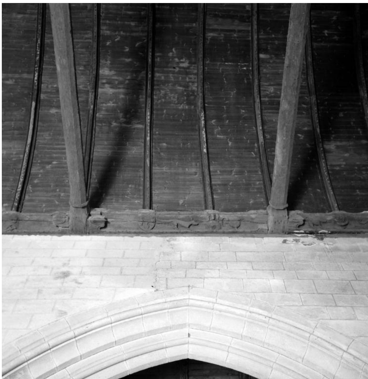
Sablières, détail du mur nord de la nef, entre entrails 4 et 5.
