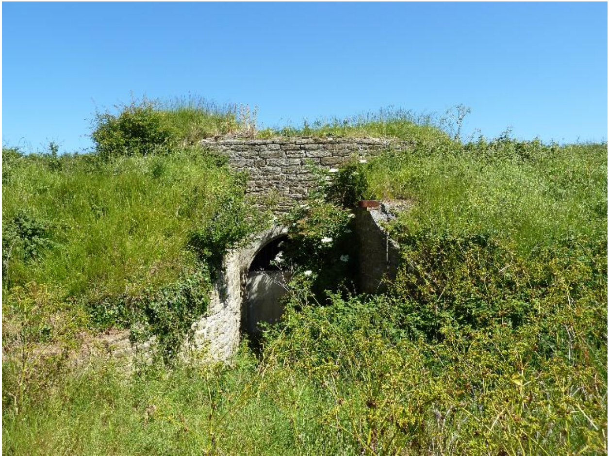
Groix, batterie du Bas-Grognon, débouché du monte-charge du magasin à poudre souterrain.
