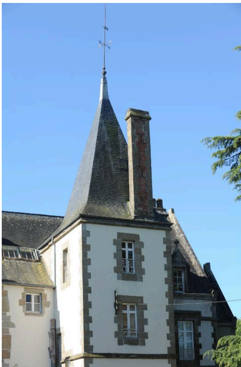
Détail de la tour façade nord
