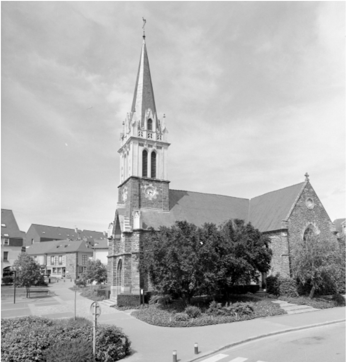
Elévation Sud-Ouest : vue générale
