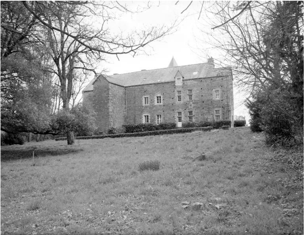
Élévation nord : vue générale
