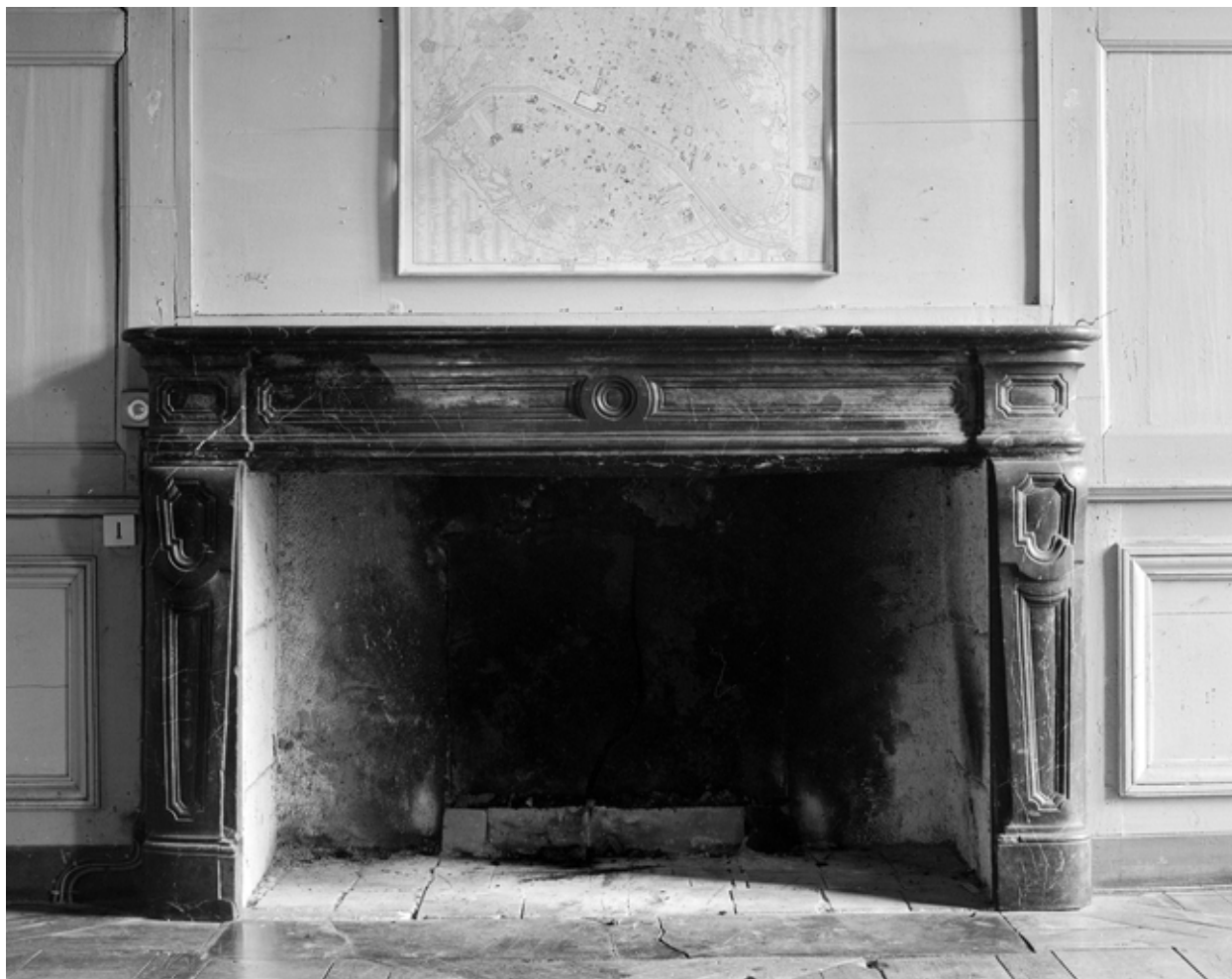
Rez-de-chaussée, bibliothèque, vue générale de la cheminée.
