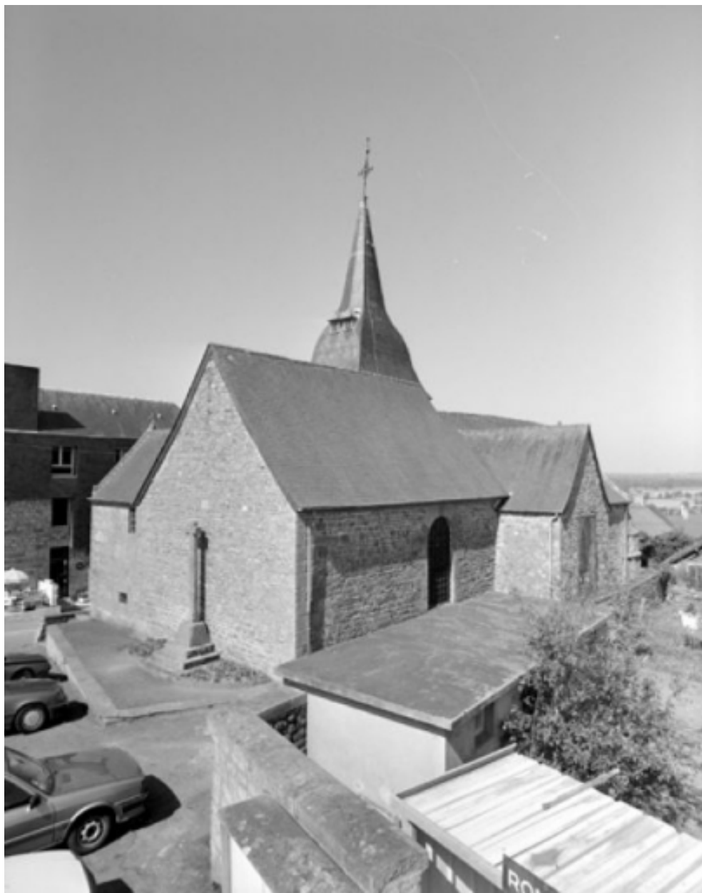
Elévation Nord-Est : vue générale
