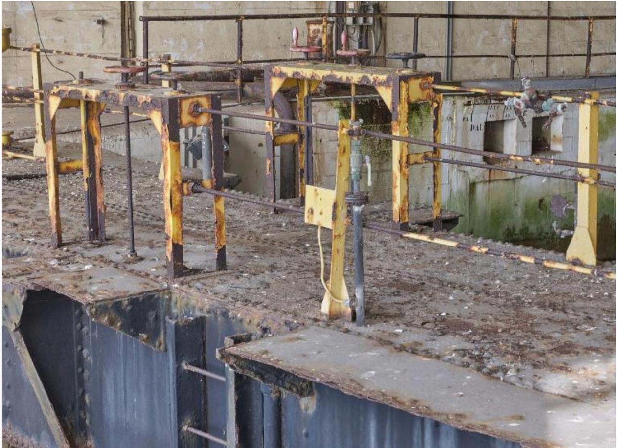
Vue des commandes des vannes de ballast du bateau-porte fermant le bassin
