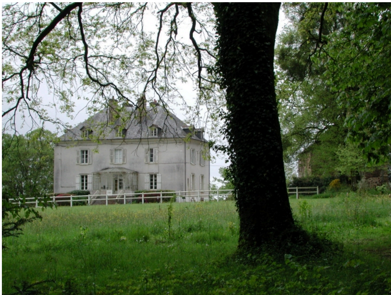
Château ; vue de situation nord
