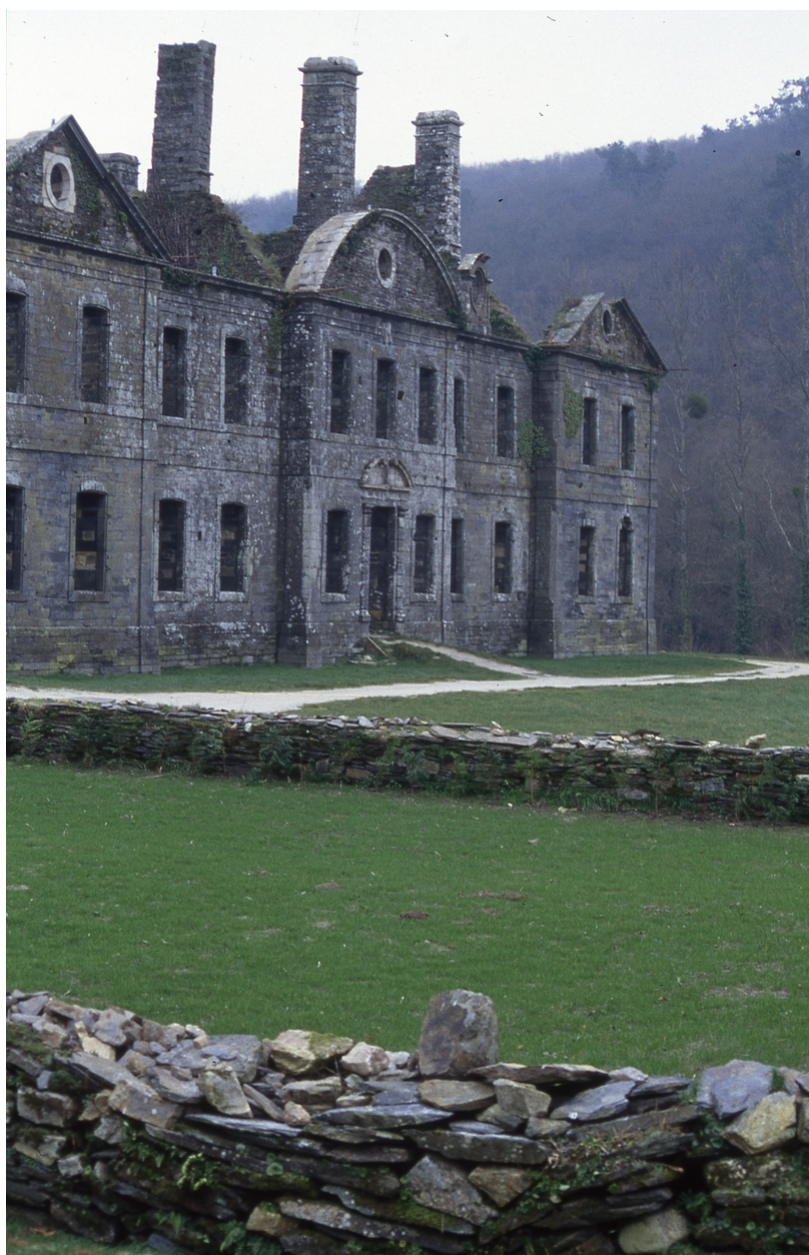
Façade principale, vue générale.
