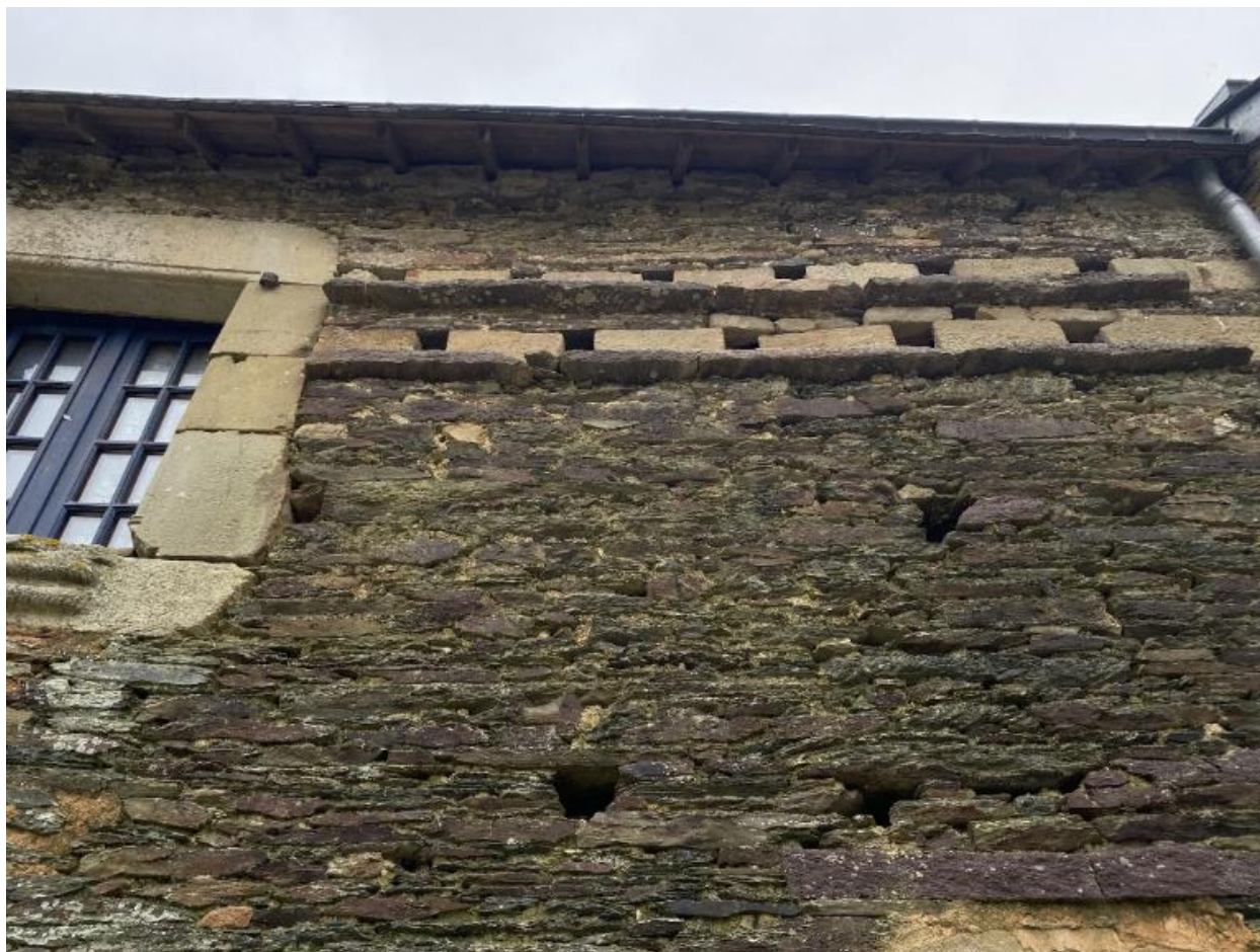
Aile nord, élévation sud, détail
