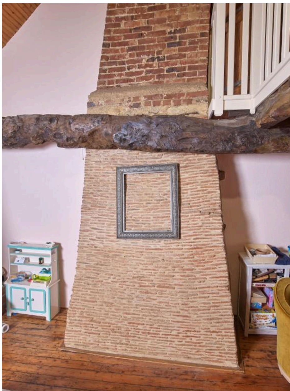
Logis principal. Chambre est de l'étage. Mur de refend. Détail du conduit de cheminée en brique
