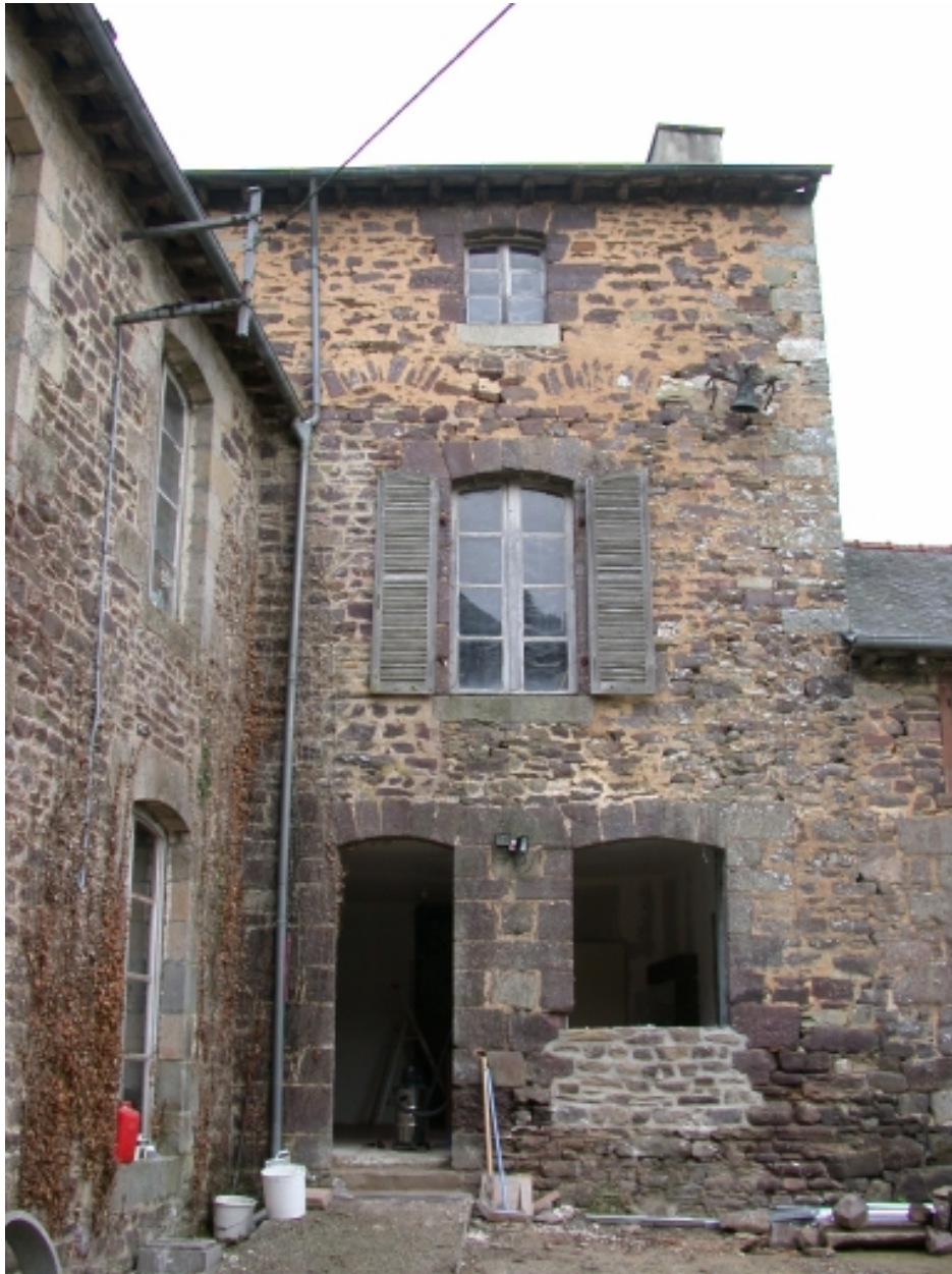
Façade arrière et départ de l'aile en retour d'équerre
