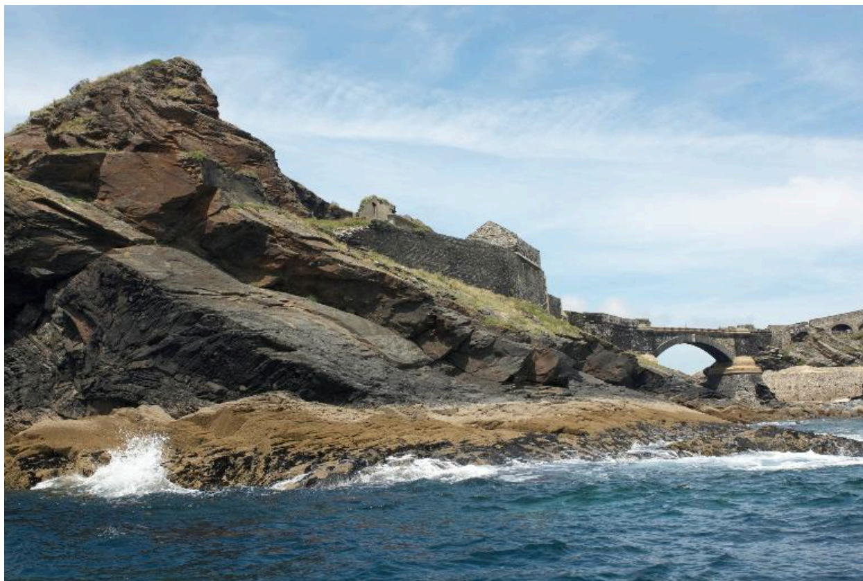
Roscanvel : vue de l'ensemble fortifié de l'îlot des Capucins depuis la mer, face ouest
