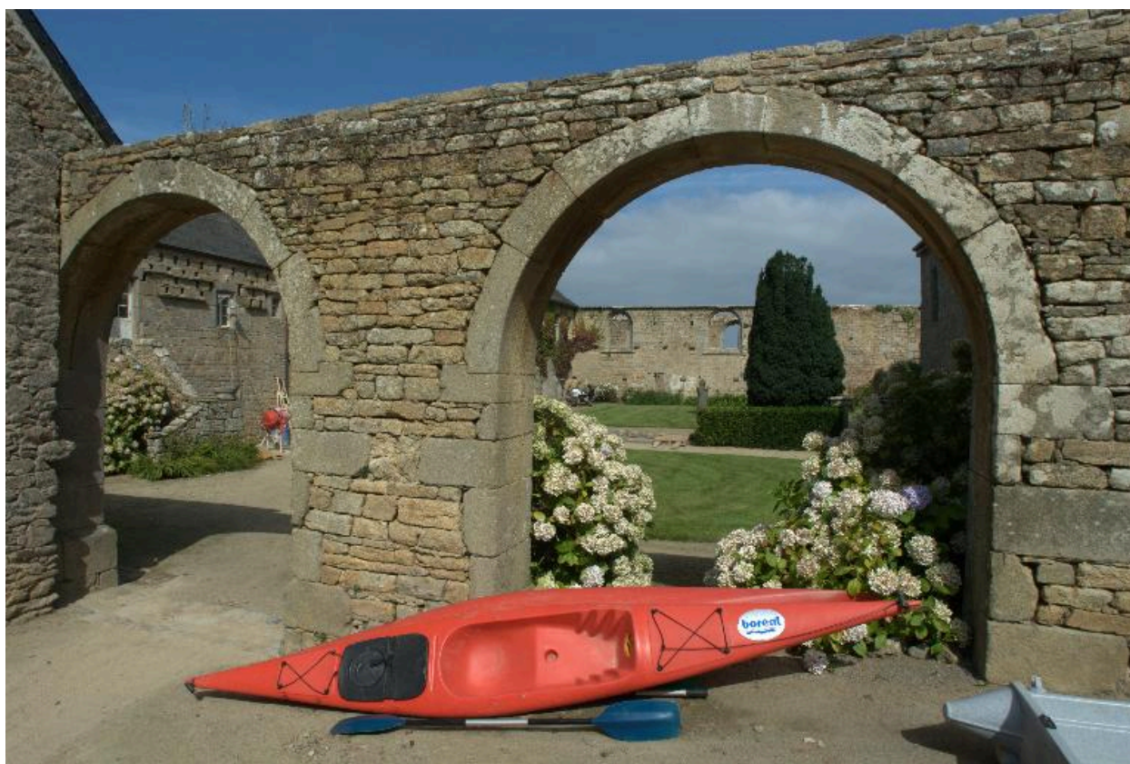
Vue des porches d'accès au sud de la cour
