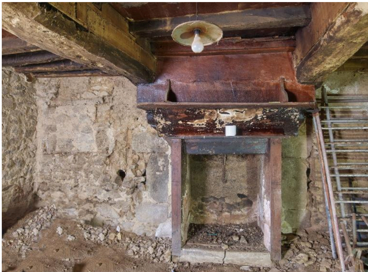
Logis sud. Pignon sud. Cheminée ancienne en pierre derrière l'habillage moderne en bois
