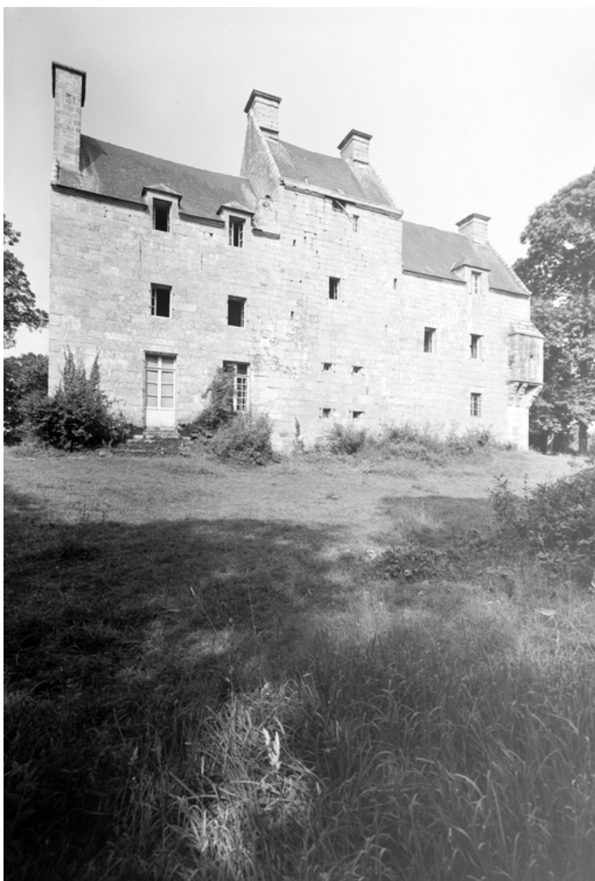
Vue générale de la face est.
