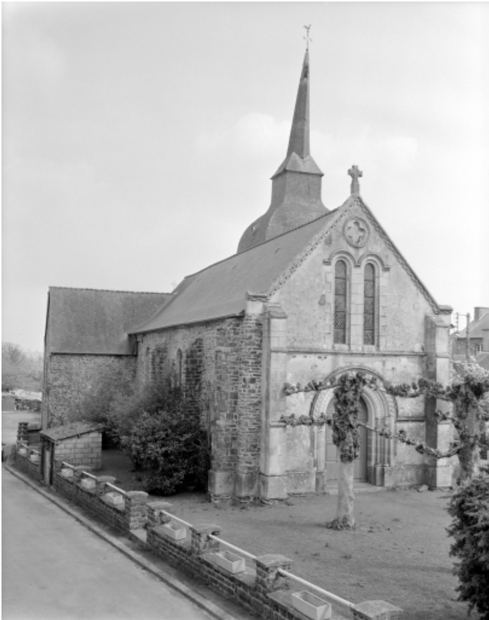
Elévation Ouest : vue générale
