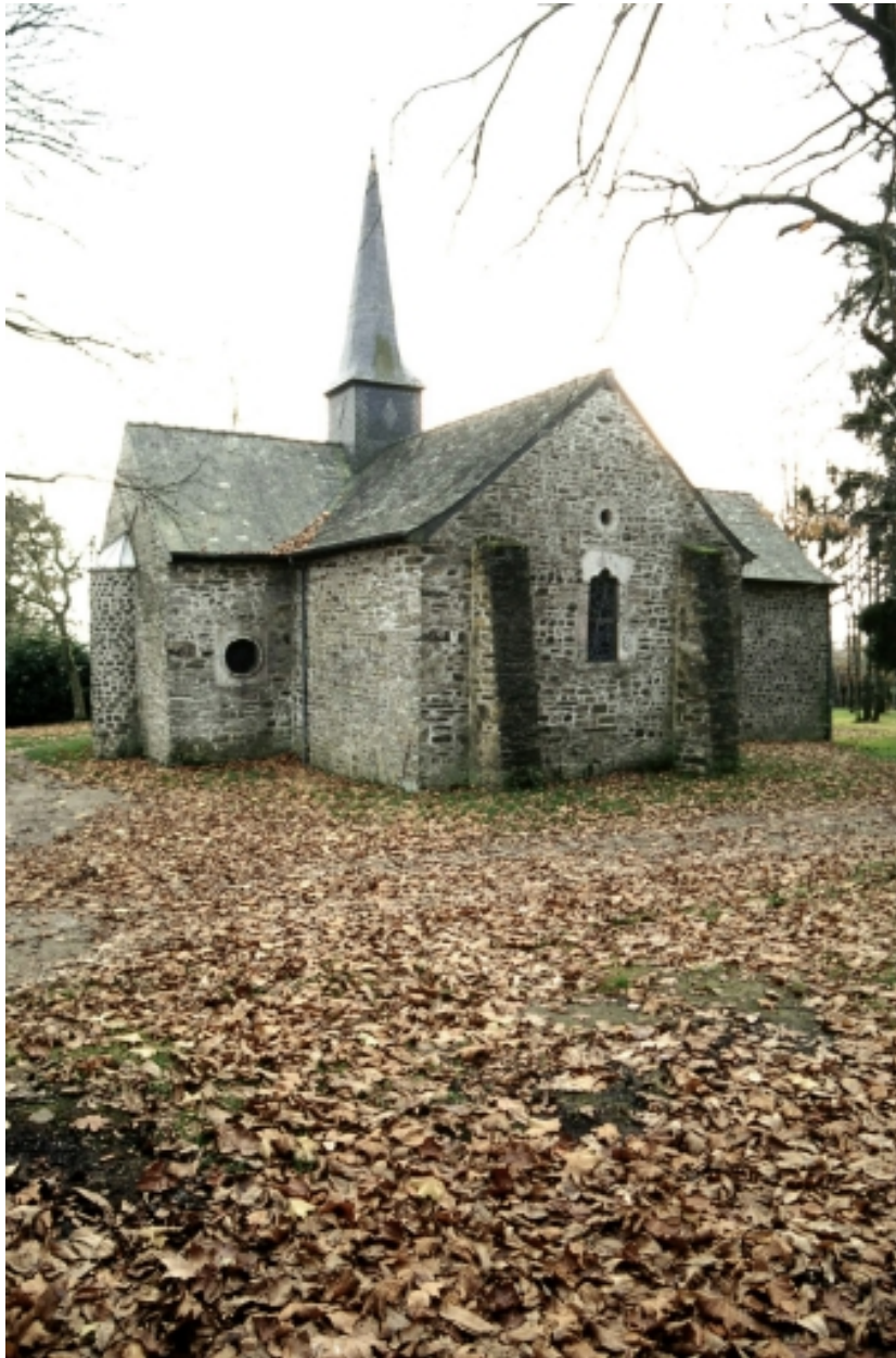
Vue générale prise du nord-est.
