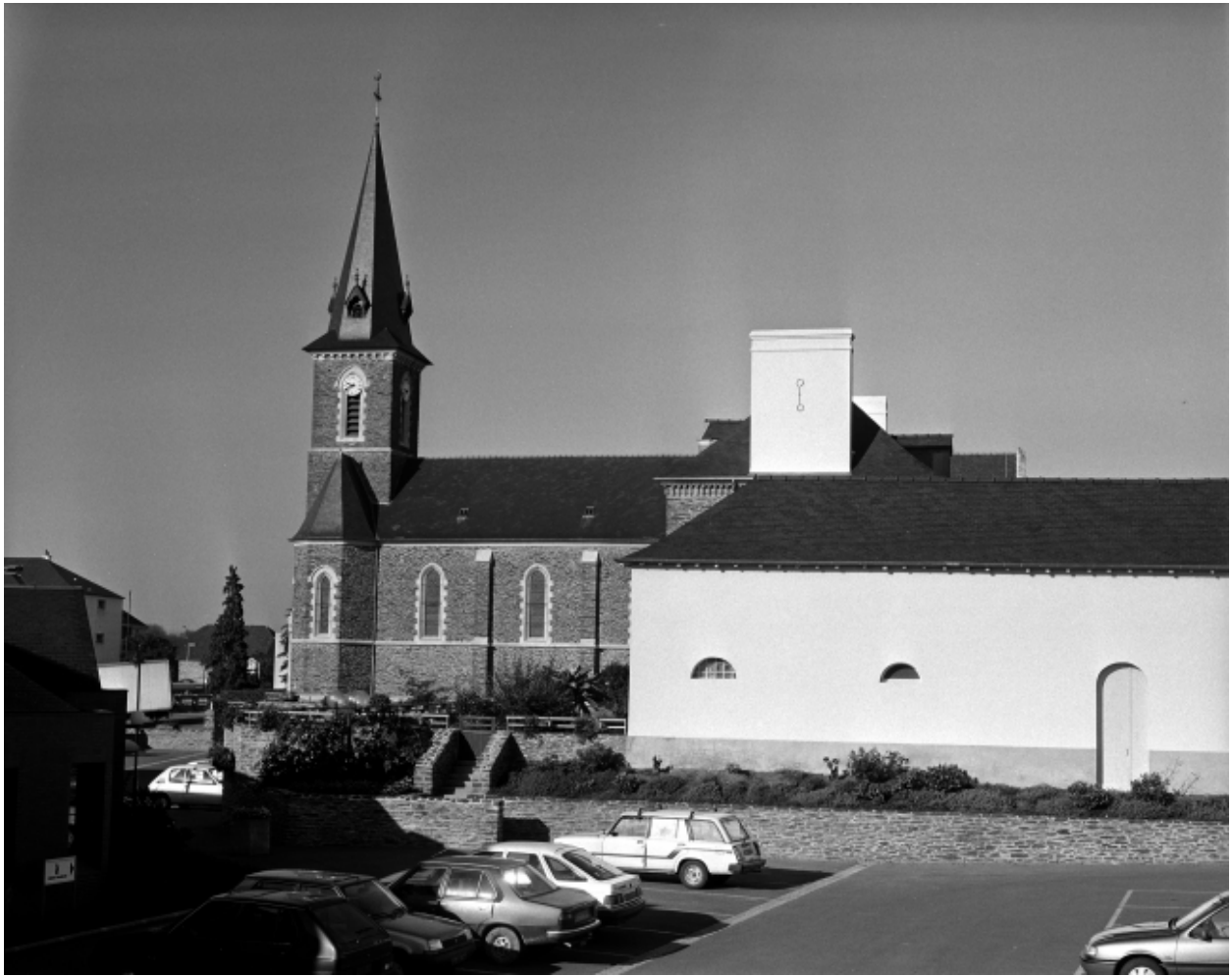
Elévation Est : vue générale
