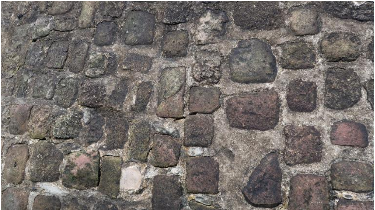
Le vieux quai du port : détail de la cale (pavés et joint)
