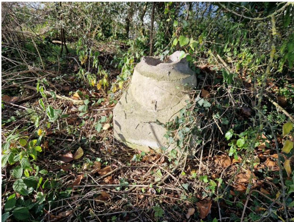
Vue de la souche de cheminée émergeant de la dalle de couverture
