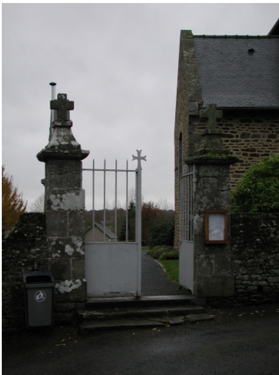
Portail de l'enclos : vue générale est
