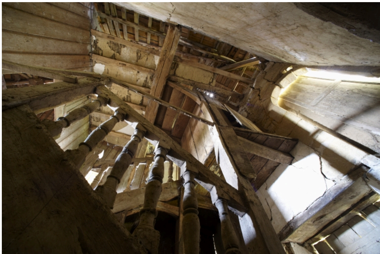
Cage d'escalier du pavillon
