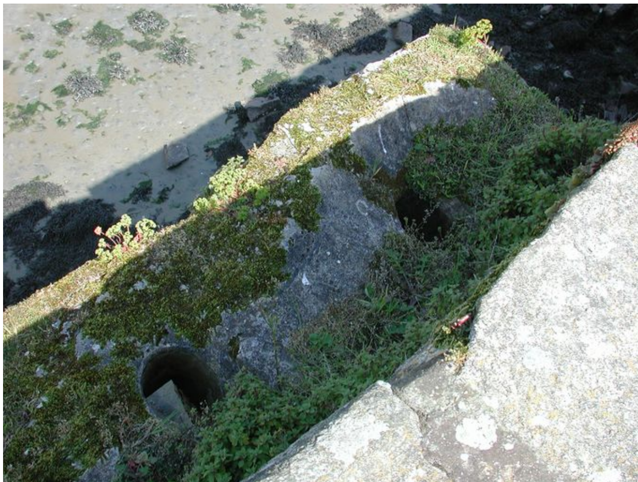
Vue des vestiges des latrines : exutoires (état en 2002)
