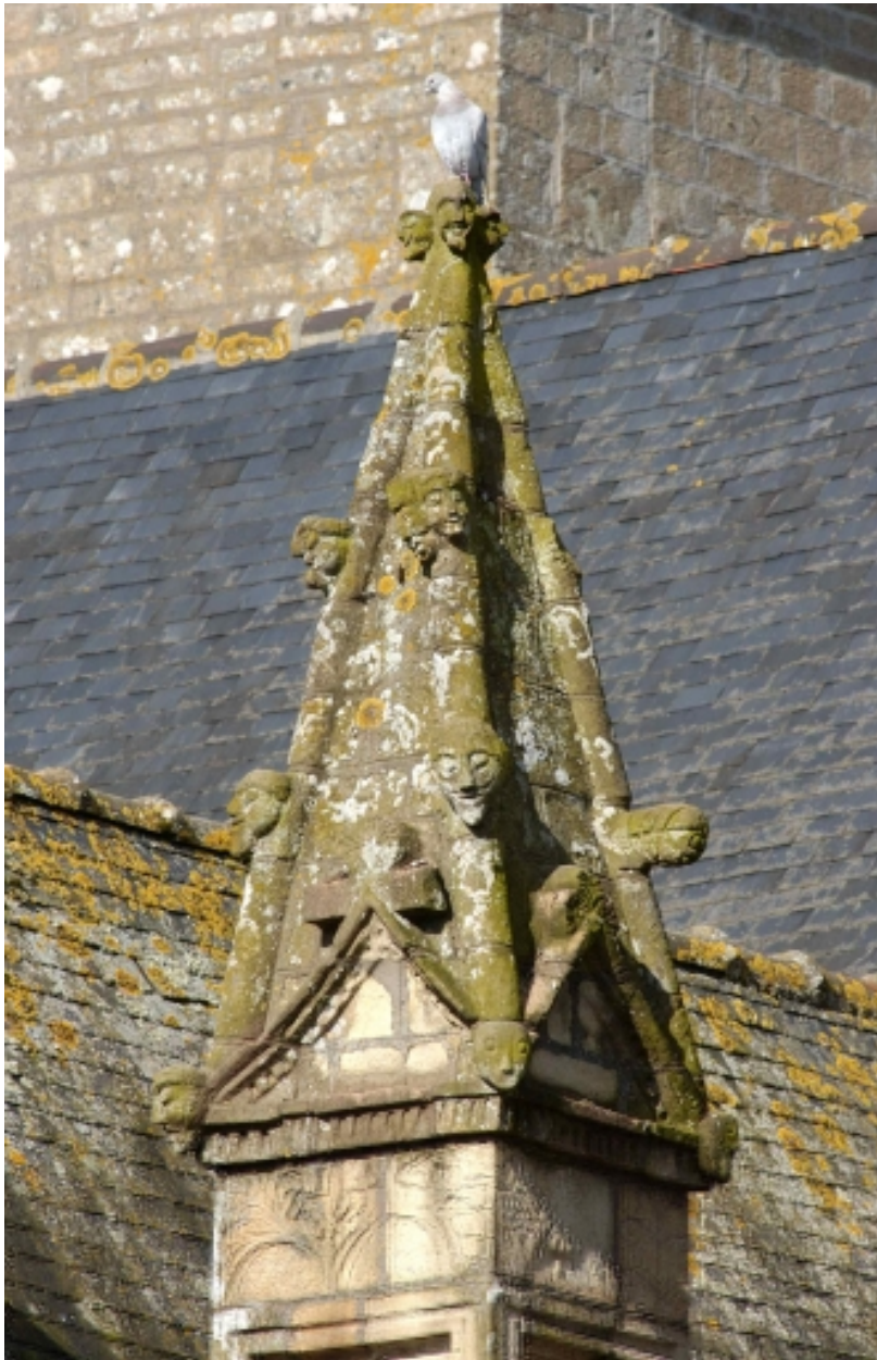
Façade sud, détail, pinacle d'un contrefort
