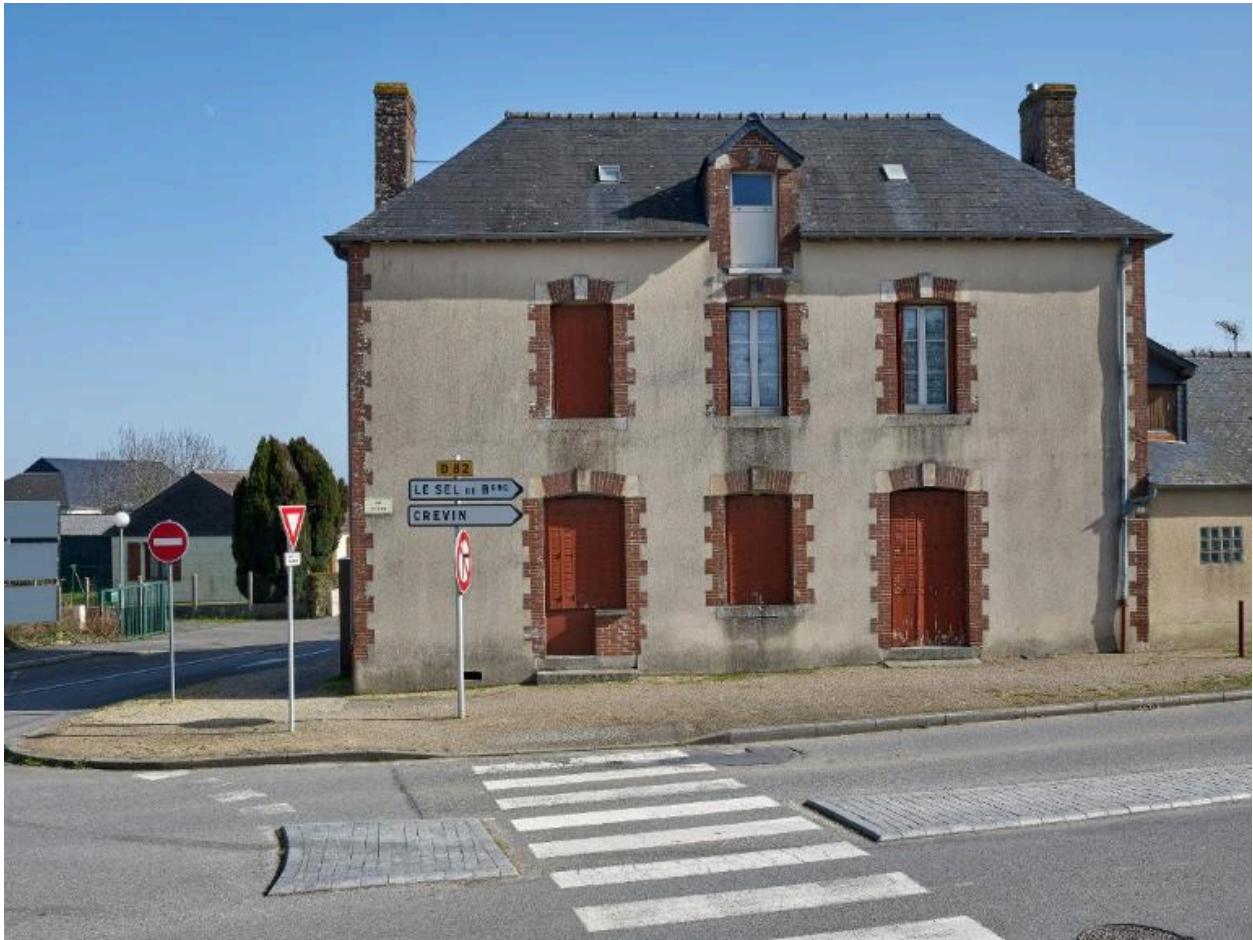
Maison construite au départ de la rue de Bellevue
