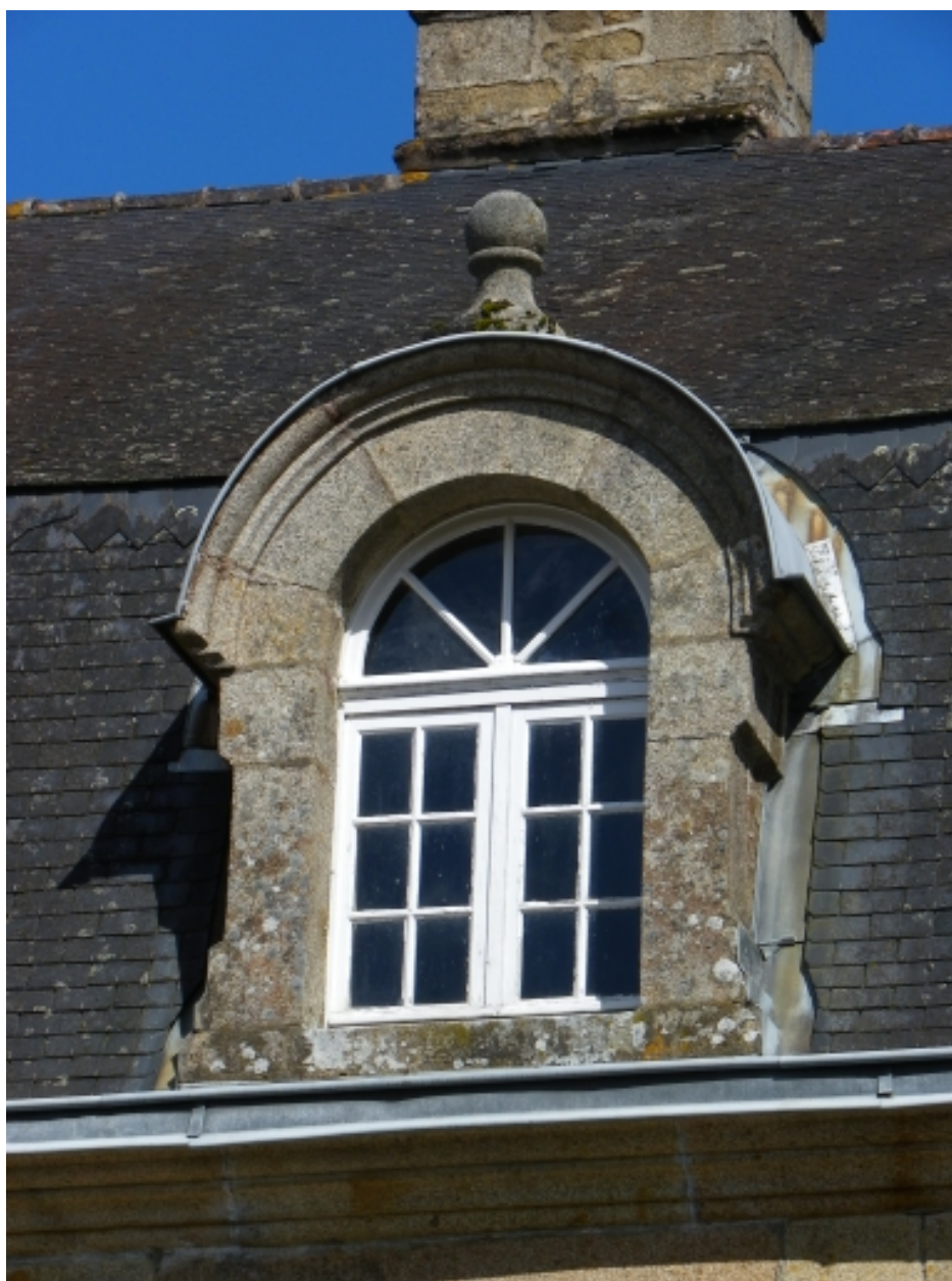
Lucarne, façade sud.
