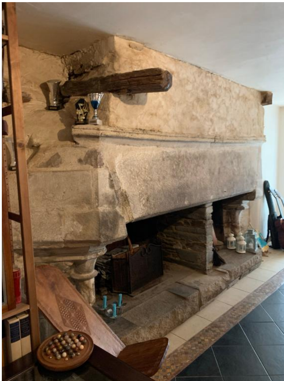
Partie ouest, rez-de-chaussée, cheminée
