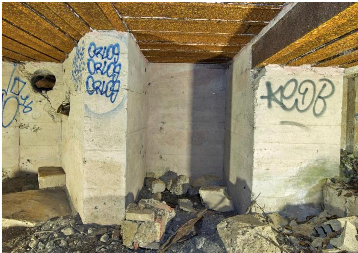
Vue intérieure : passage d'entrée, mur Ouest ; au centre, soute à munitions (dans laquelle se trouve l'inscription) ; à gauche : tuyaux du système d'aspiration et d'évacuation des fumées de tir (le ventilateur a disparu) ; à droite, entrée
