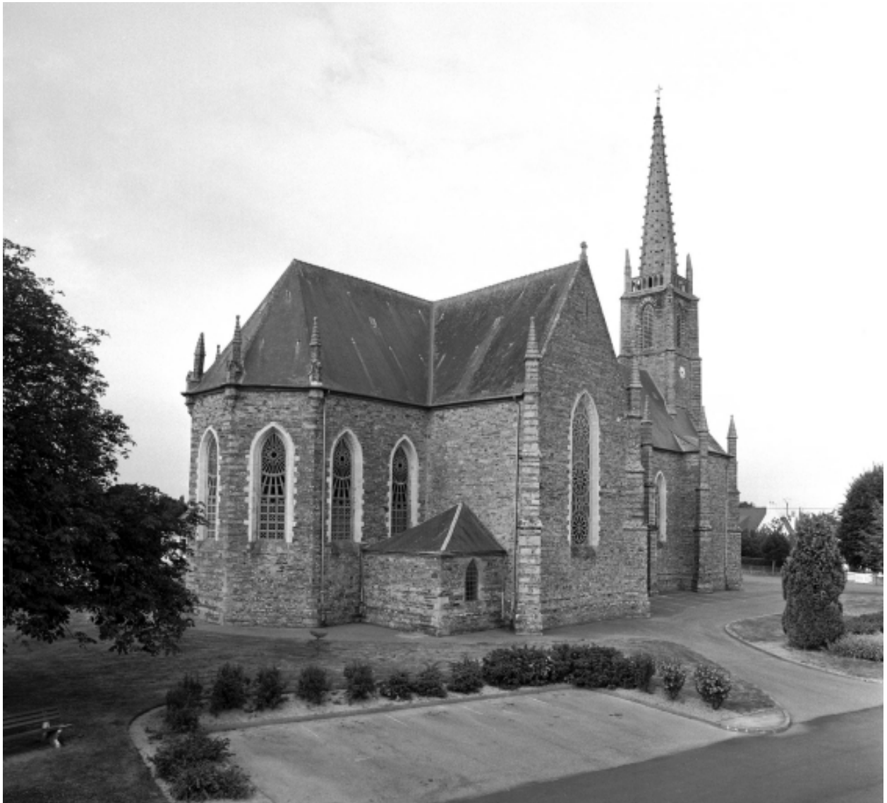
Vue générale : élévation nord-est
