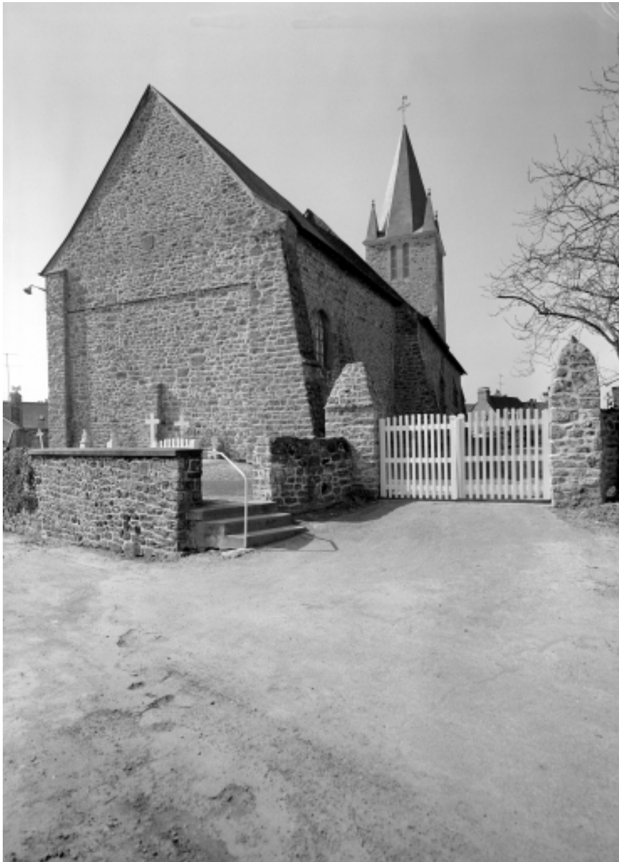
Elévation nord-est : vue générale
