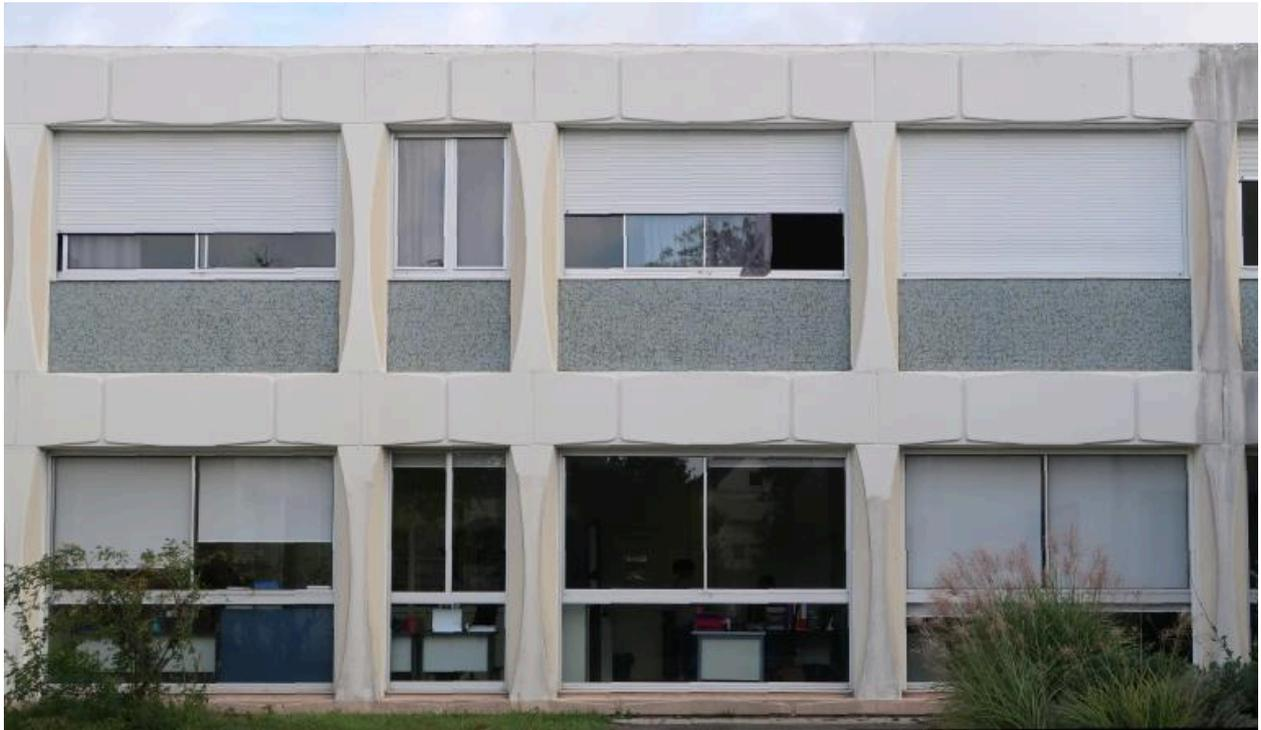
Détail de la modénature de la façade sud de l'externat (bâtiment A), noter l'alternance de travées larges et étroites, le moulage des poteaux en béton armé, les formes courbes soulignées de jaune-paille, les panneaux de grès bleu-nuit, gris-bleu.
