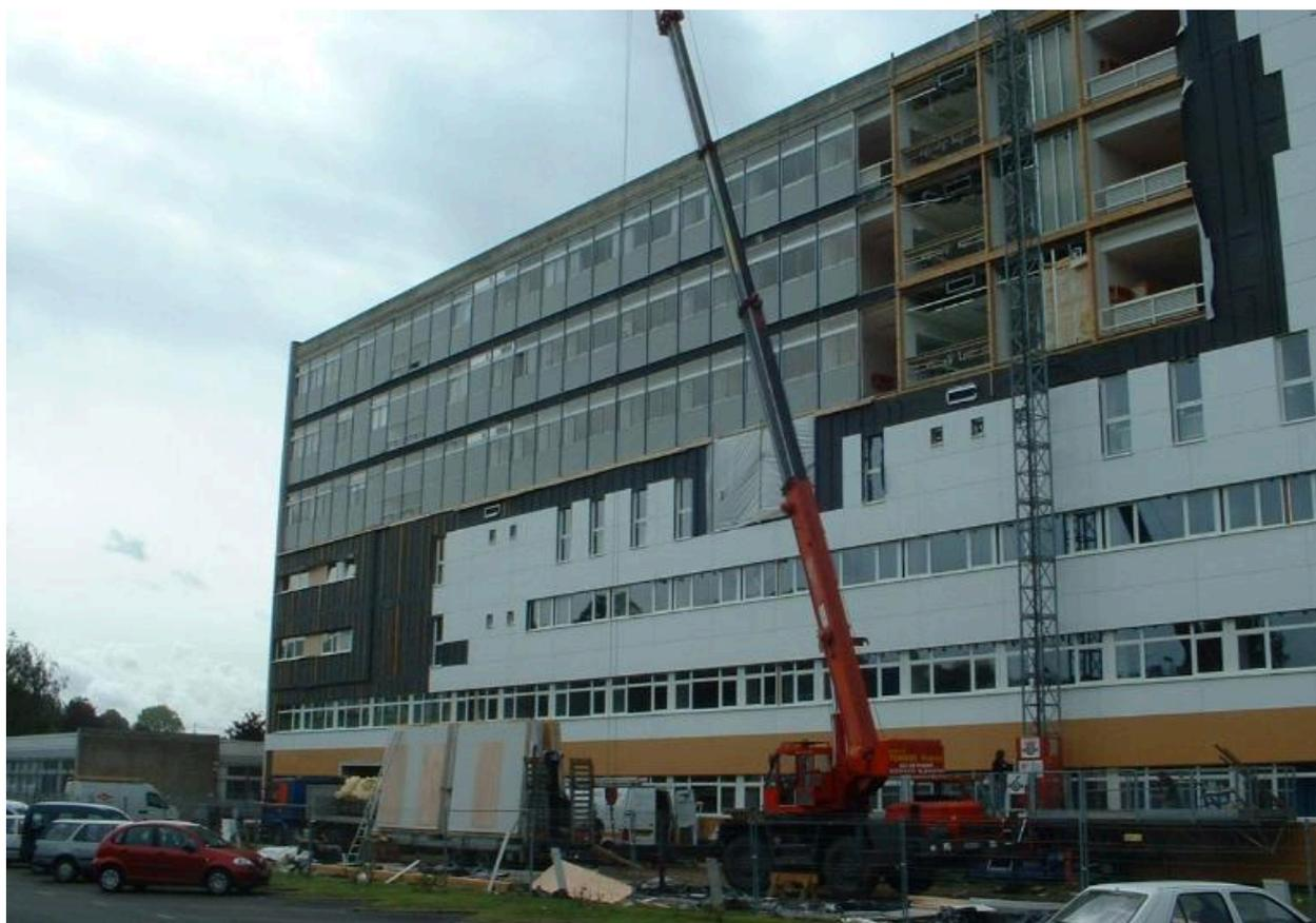
Façade est de l'internat en cour de restructuration. On aperçoit la structure après dépose des éléments de la façade rideau d'origine.
