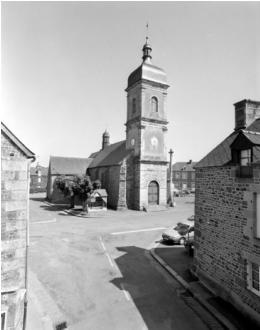
Elévation ouest : vue générale
