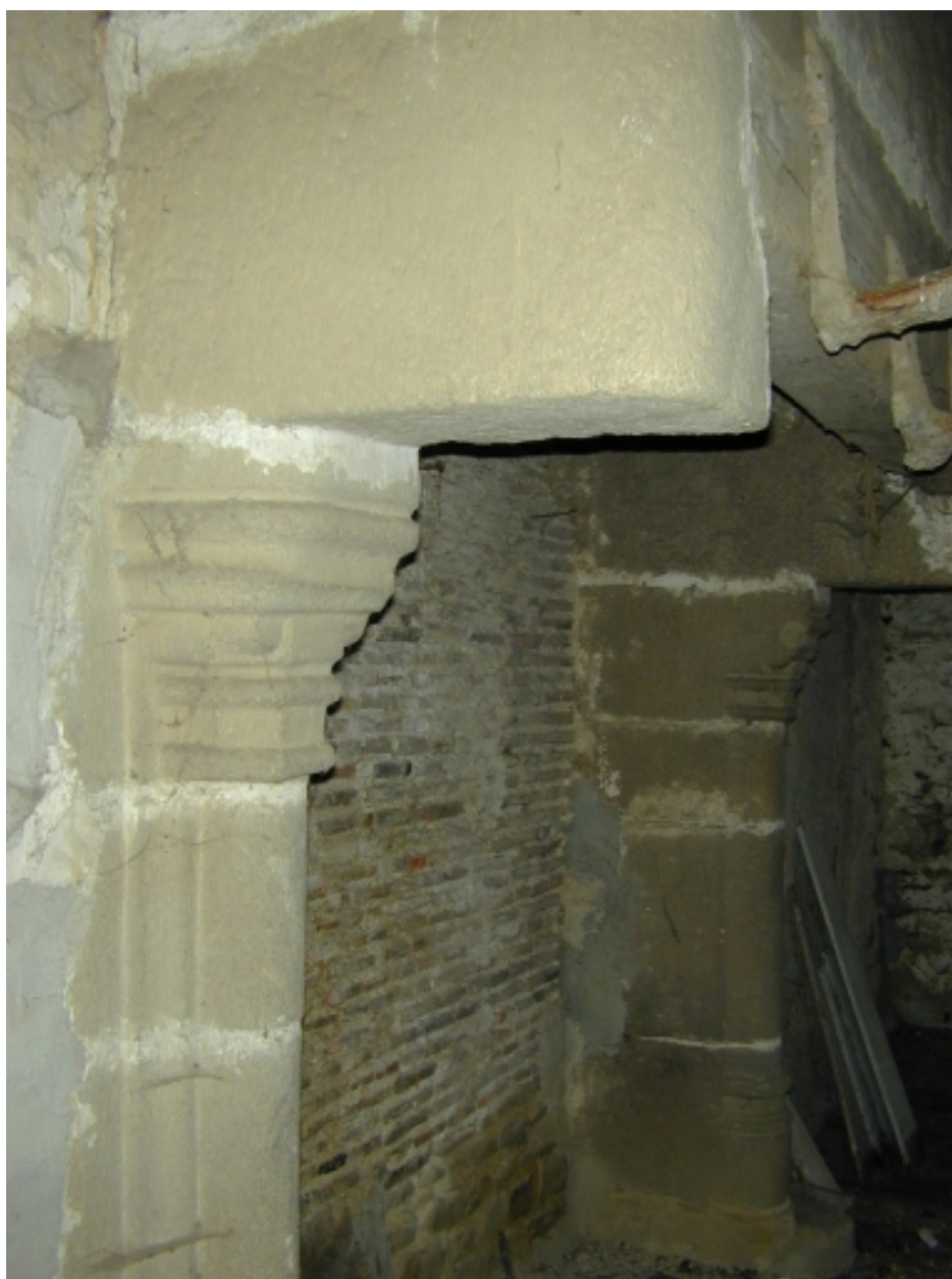
Intérieur, 1er étage, cheminée du 15e siècle : console du piédroit
