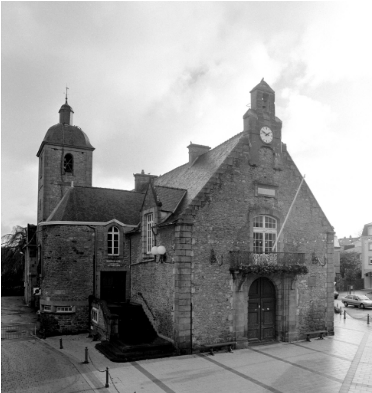
Elévation ouest : vue générale
