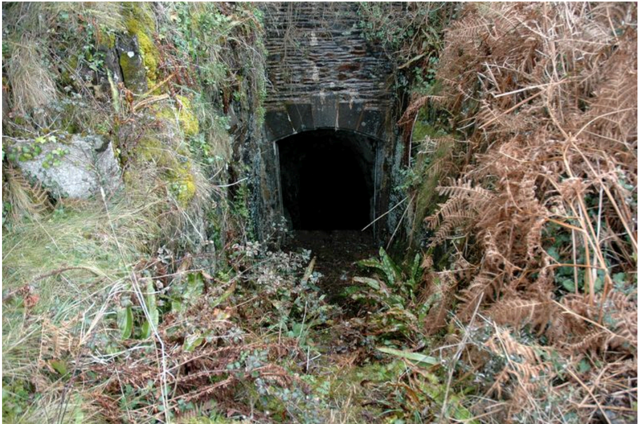
Vue de l'entrée de l'escalier (état en 2007)
