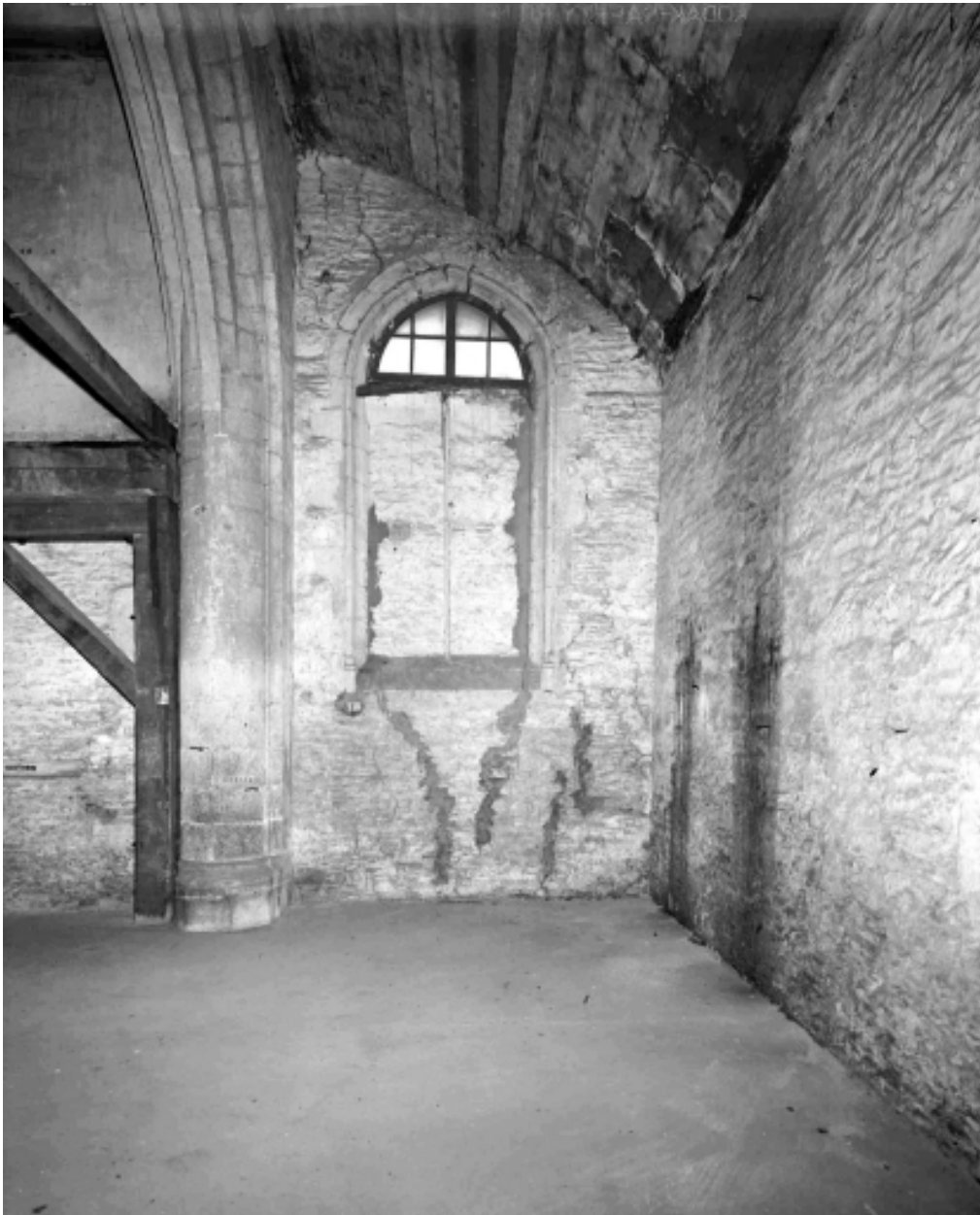
Collatéral nord, mur ouest
