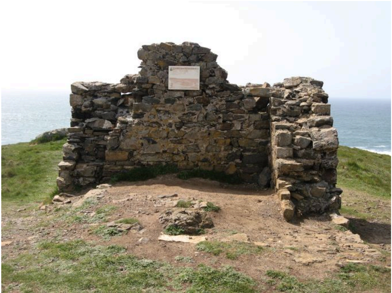
Corps de garde de Lostmarc'h
