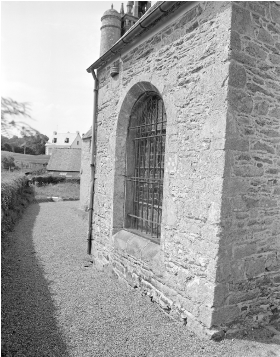
Fenêtres du transept sud
