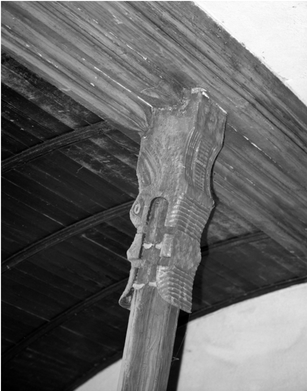
Intérieur, chapelle nord n°3, sablières et entrait : vue générale
