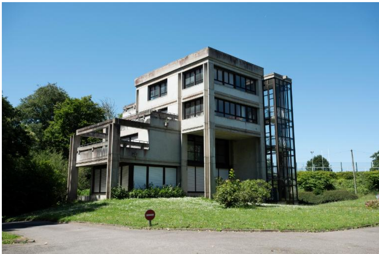
Logements de fonction, façade est et verrière de l'escalier.
