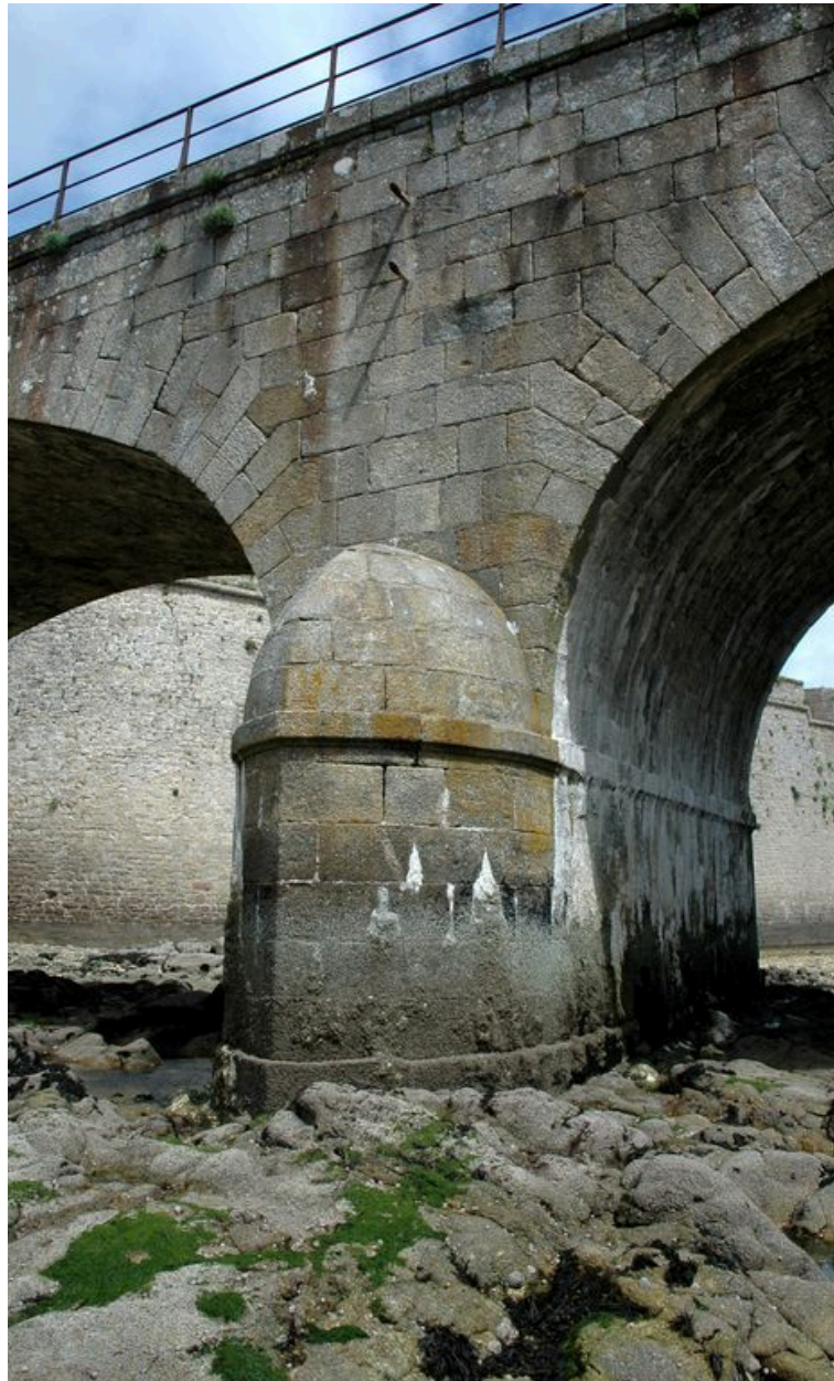
Vue de la citadelle de Port-Louis : pile du grand pont en granite permettant de franchir le canal
