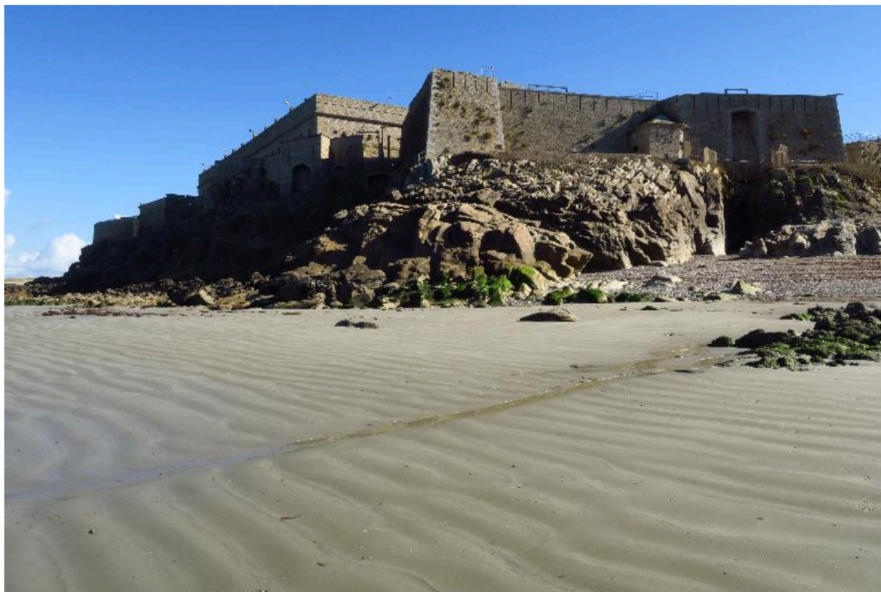
Saint-Pierre-Quiberon, fort de Penthievre, enceinte, fronts ouest.
